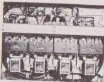
AC Cooling Fan Contactors Fig. 3-4
